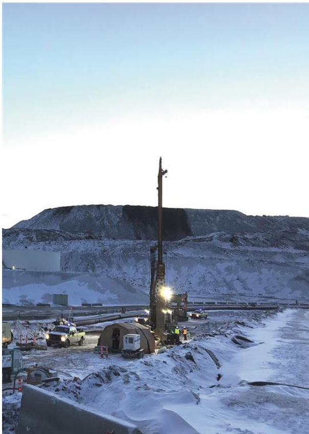
(1) Rund 170 km nördlich des Polarkreises führte BAUER Foundation Corp. Feldversuche mittels Düsenstrahl- und Cutter-Soil-Mixing-Verfahren aus.
